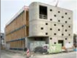
Im Rohbau ist der Holzbau zwischen den Betonkernen deutlich zu erkennen.
