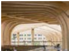
Die gebogenen Brettschichtholzteile wurden computergesteuert präzise zugeschnitten.
